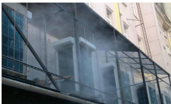
На фото: адиабатическое охлаждение наружных блоков кондиционеров
