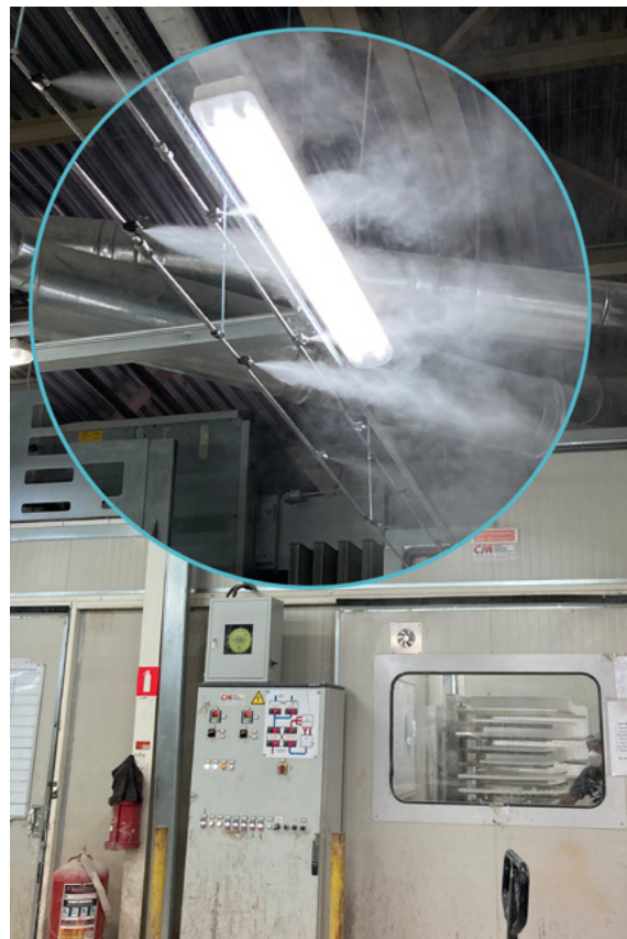
На фото: Увлажнение воздуха перед покрасочной камерой (покраска стульев)
